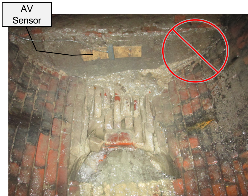
Hach AV on Weir Wall
