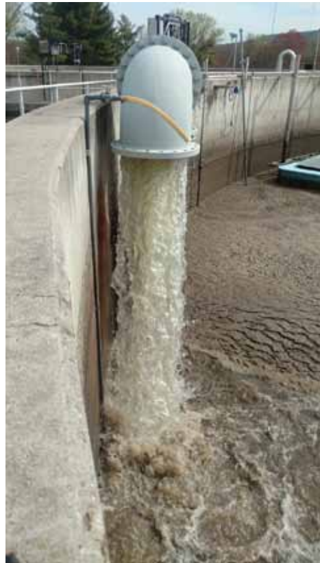
SBR fill pipe
