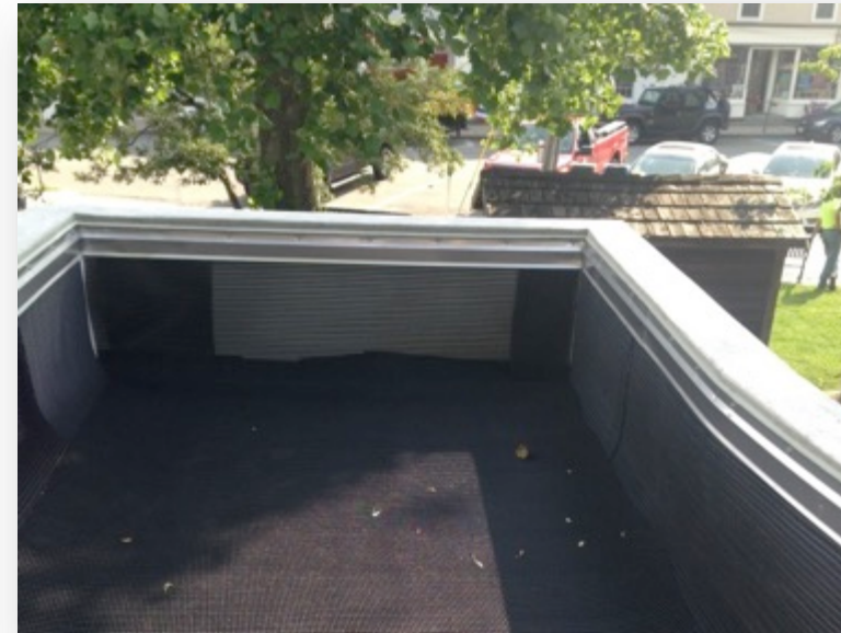
Tri-Planar Geonet Media Barrier
