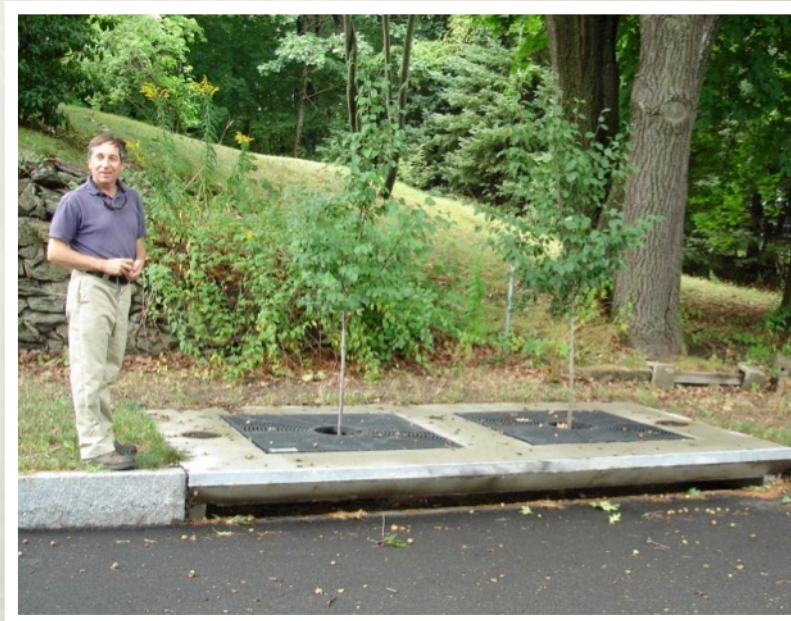
Holm Ave Sewer Separation 2009-2010
