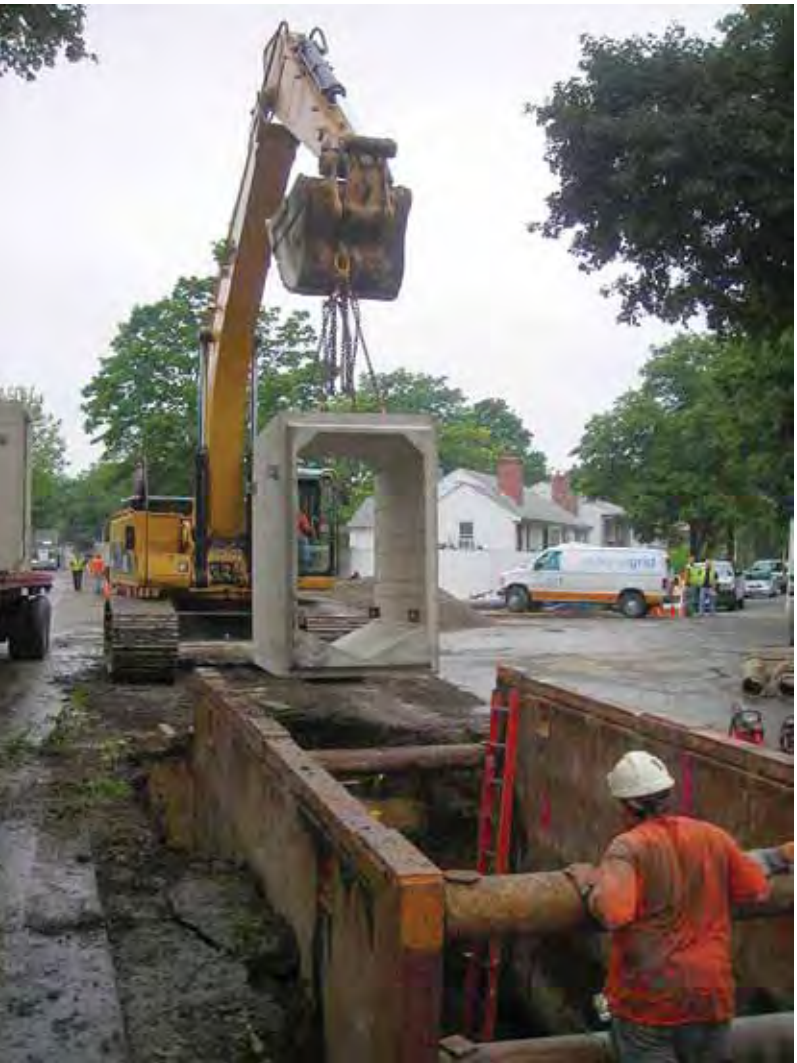
Storage conduit installation
